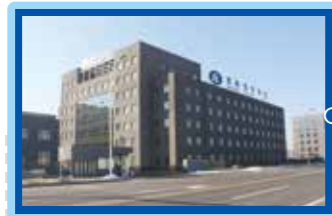
沈阳总部 Shenyang Head Quarters
